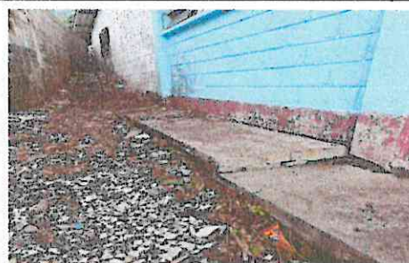
Foto 8: Reparación de muro perimetral de block.
