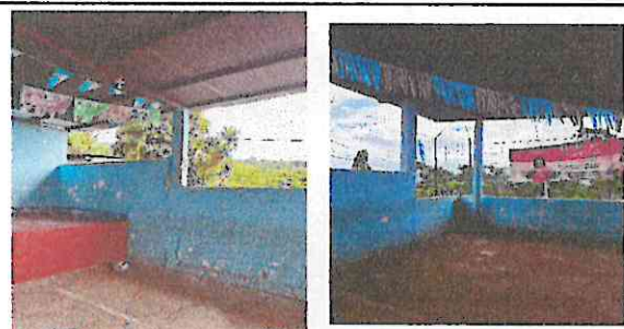
Foto 9: Sustrucción malla galvanizada en muro perimetral.
