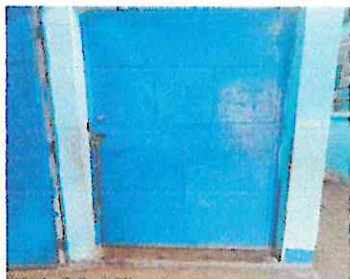
Foto 5: Mantenimiento de puertas de metal chapas lijado y pintura.
