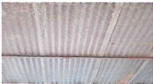
Foto1: Sustitución de lámina acanalada por troquelada en galera de usos multiples.
