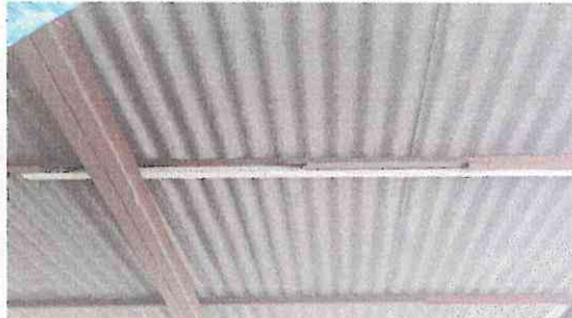
Foto 2: Sustitución de soporte de metal por metal en galera de usos multiples.
