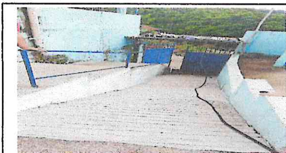
Foto 7: Sustrucción de barandas de metal en pasillos.
