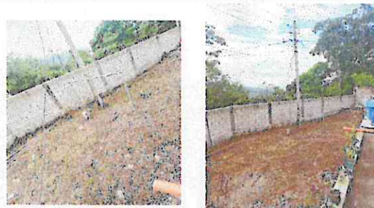
Foto 10: Reparación de losa de patio.
