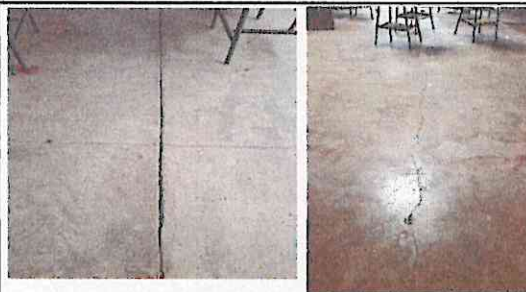
Foto 6: Sustitución de piso de concreto por piso de granito en todos los salones.
